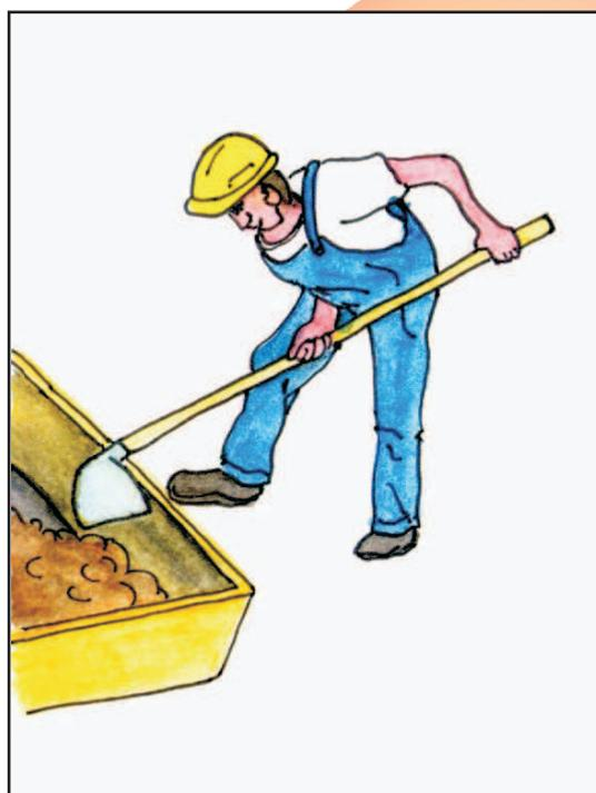
Misturar com água com enxada em uma masseira convencional que esteja limpa e desengrachada e livre de resíduos de cal até o ponto de reboco.
